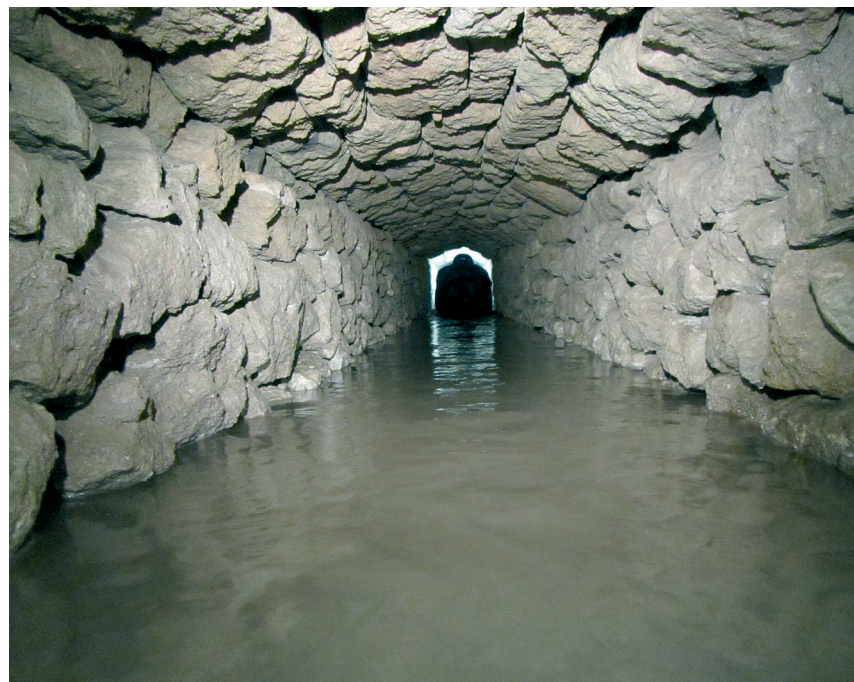
Galerie réseau 2. Cliché ASSE
